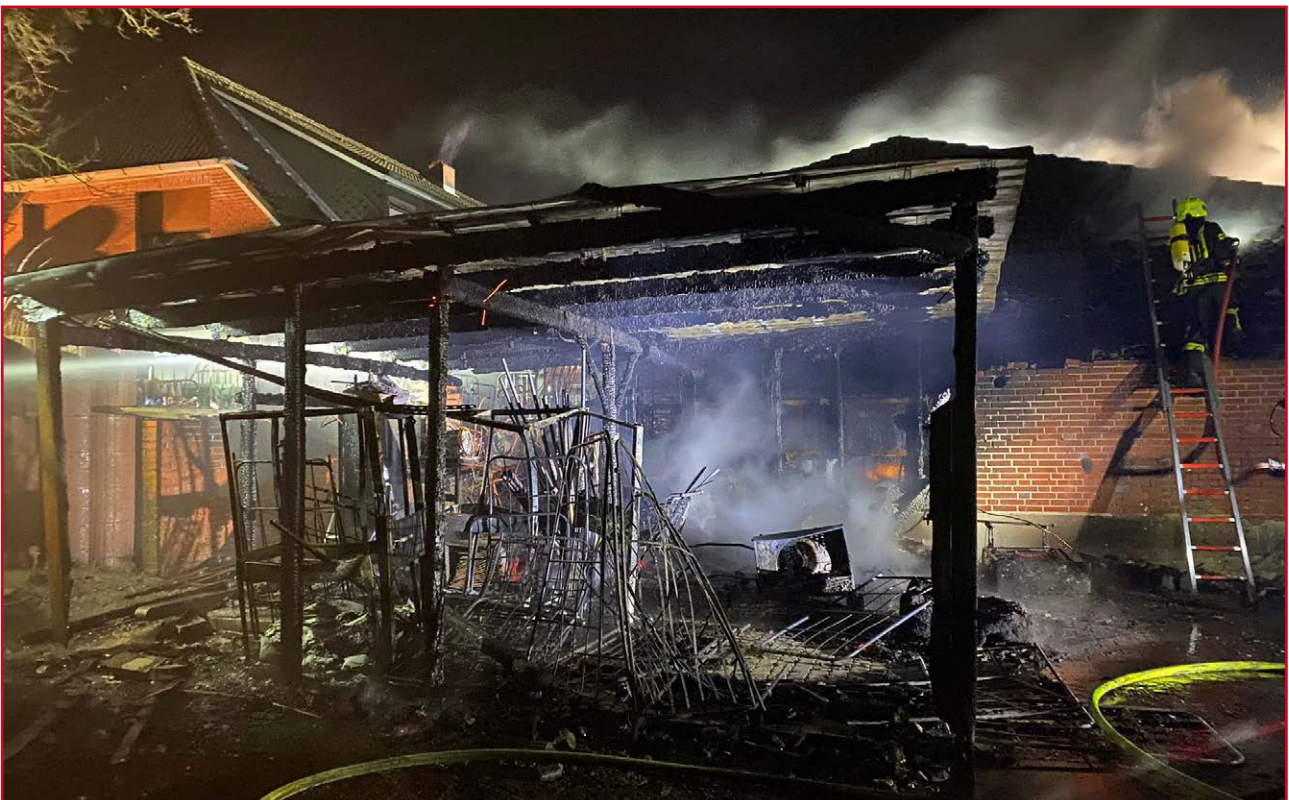
Der Anbau des Lebensmittelgeschäftes brannte völlig aus.
