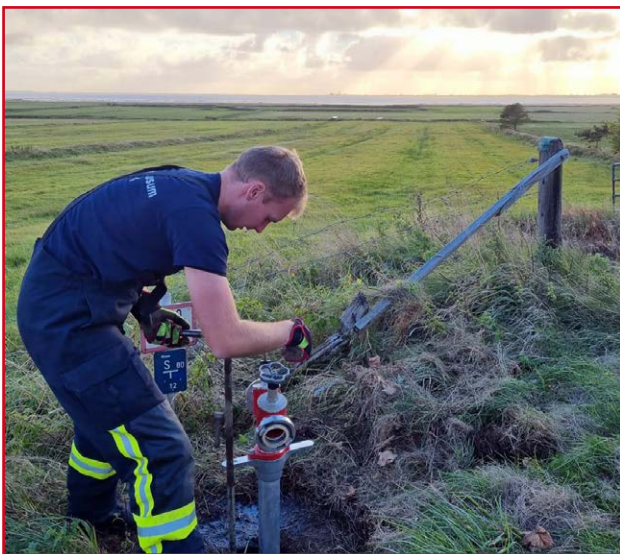
Timo Ketelsen bei der Hydrantenkontrolle.
