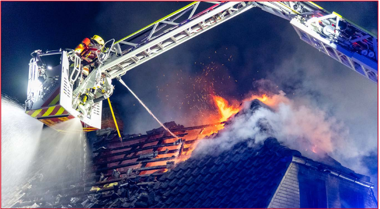
Dachöffnung von der Drehleiter aus
