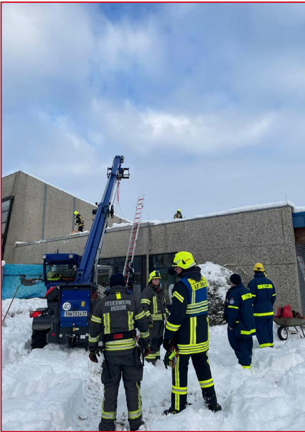
Zusammen mit dem THW wurde die Schneelast entfernt.
